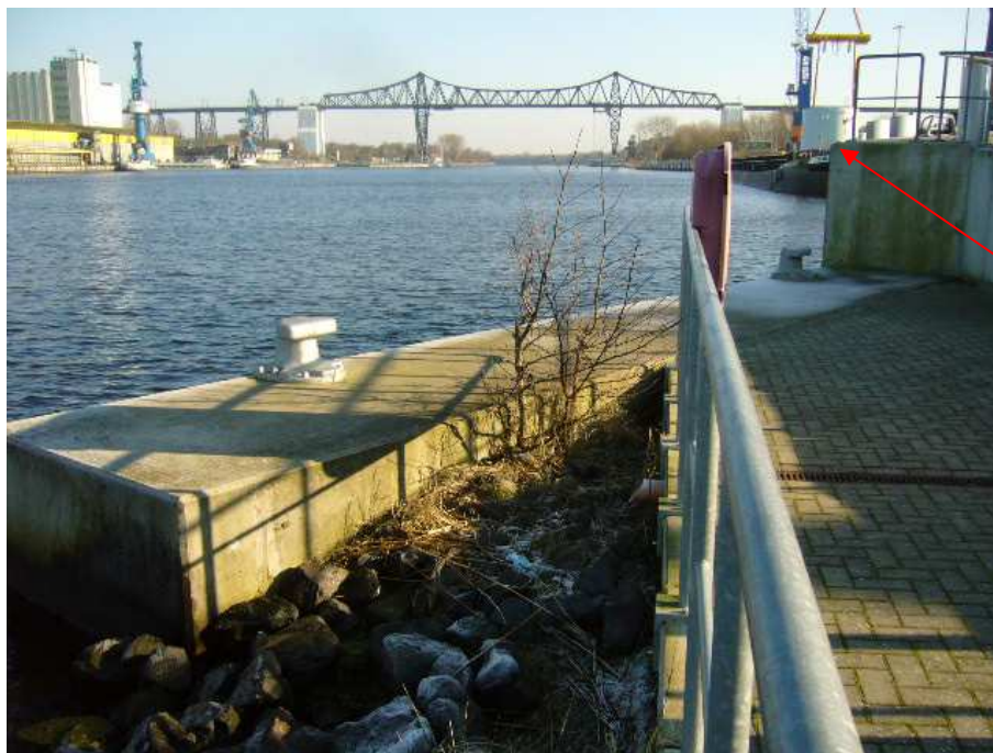
Vorhandener Anleger Südseite
