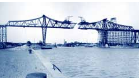
Eisenbahnhochbrücke Rendsburg im Bau
